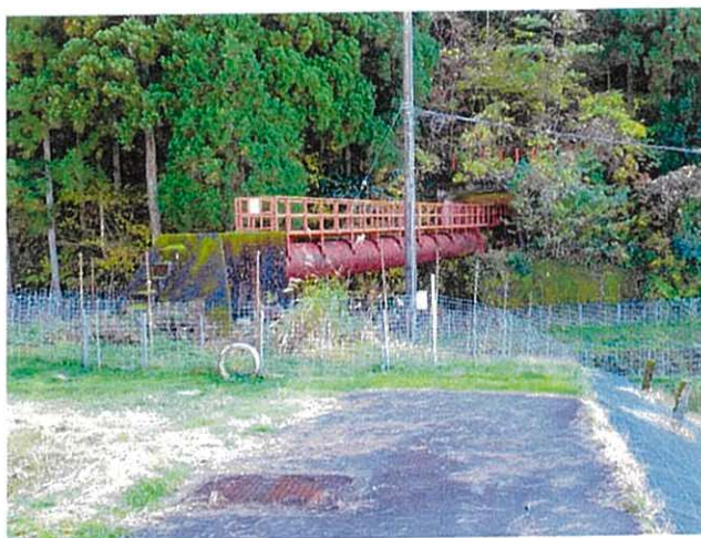
共通幹線用水路 鉄管橋 (愛本新用水土地改良区)
