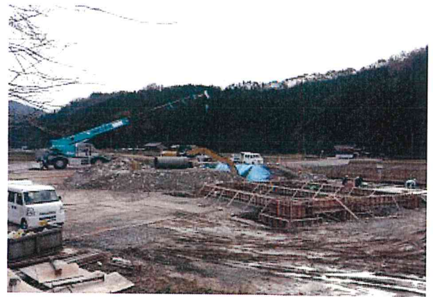
地域用水環境整備事業 小川用水地区 (発電所建屋建設工事風景)
