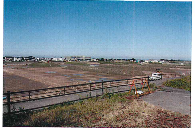
経営体育成基盤整備事業 舟川新地区 (ほ場整備工事風景)
