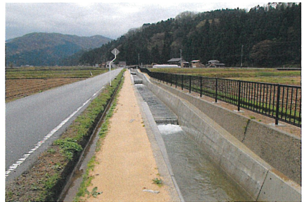
基幹水利施設ストックマネジメント事業 小川幹線地区 (水路改修後の通水風景)
