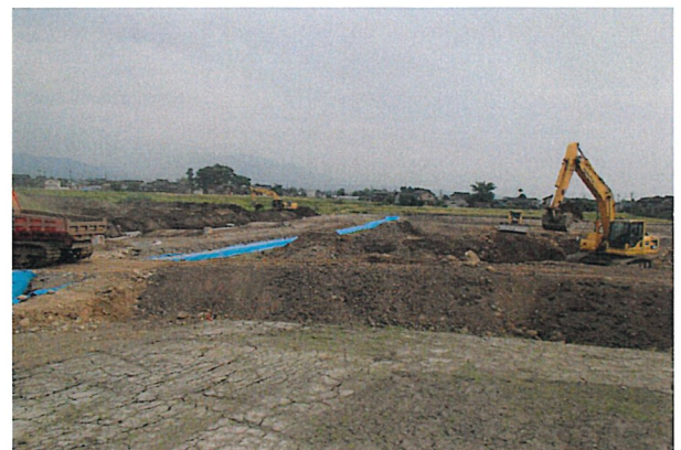
経営体育成基盤整備事業 窪田地区 (ほ場整備工事風景)
