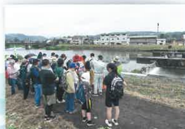
大坪用水頭首工
