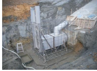
◆底樋工事状況◆
