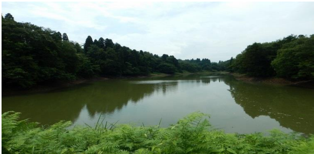
◆全 景◆ (熊ヶ谷池)
