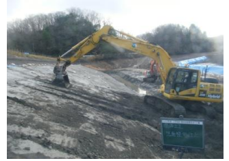
◆堤体工事状況◆
