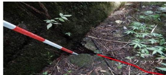
◆洪水吐底版が陥没状況◆
