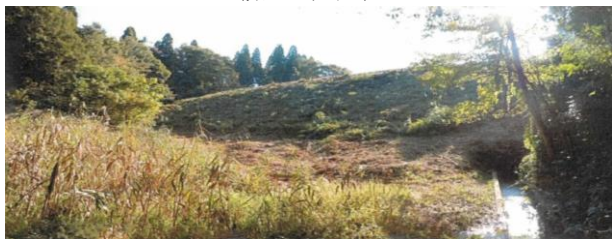
◆堤体法面の劣化が進行している状況◆
