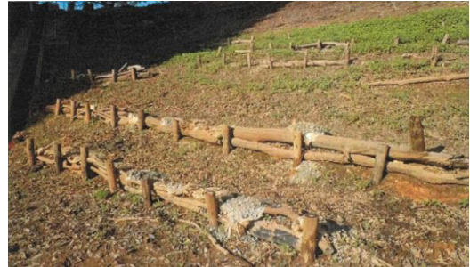
◆堤体法面が崩落状況◆
