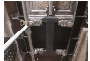
導水路制水ゲート
