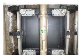
取水ロゲート
