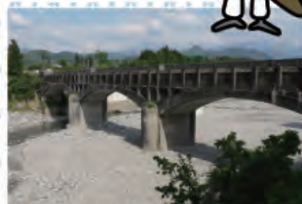
左岸側に水を運ぶ連絡水路橋
