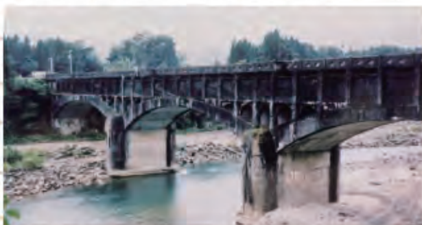
平成 10 年の左岸連絡水路橋
