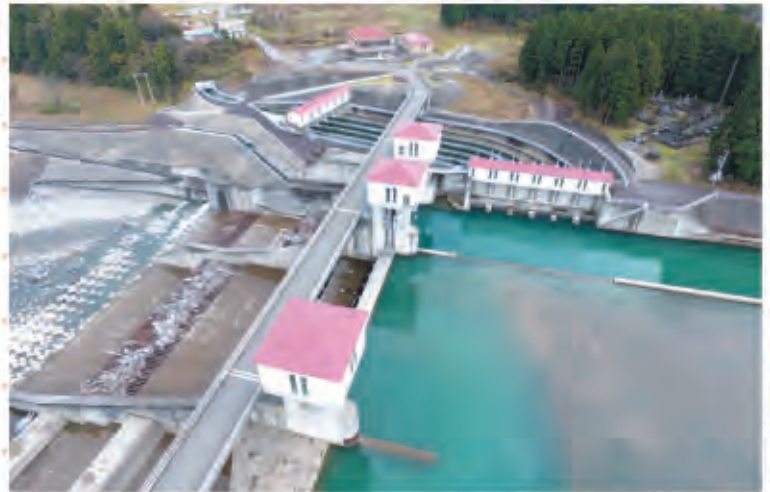
完成した横江頭首工
