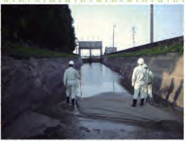
水路の点検の様子
