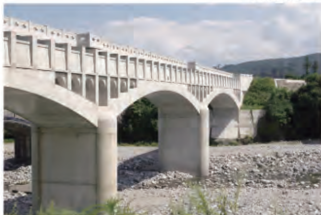
左岸連絡水路橋
