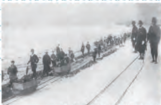
森山知事による工事視察の様子 出典:常西合口用水誌(3)
