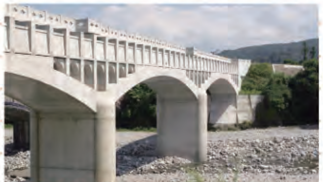
アーチ型の左岸連絡水路橋
