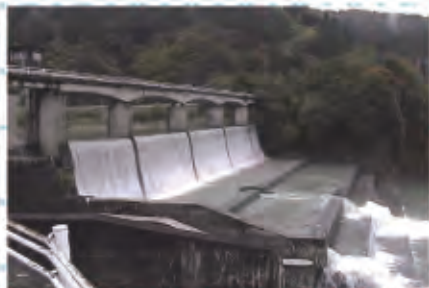
取水が一本化された横江頭首工
