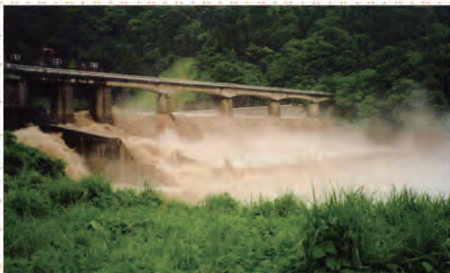
横江頭首工を流下する土石流
