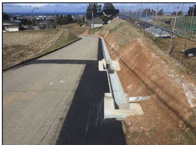
中山間地域農業農村整備事業 いかわ広域2期地区(阿古屋野)
