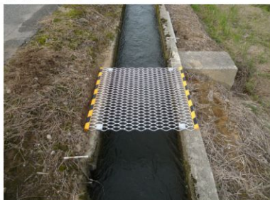
水口周辺 (警告色端部カバー装着)
