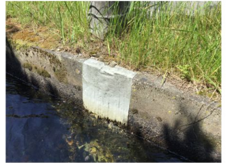
強固に密着し 水漏れを止めています
