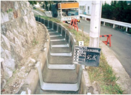
BF水路 施工当初 (1998年)
