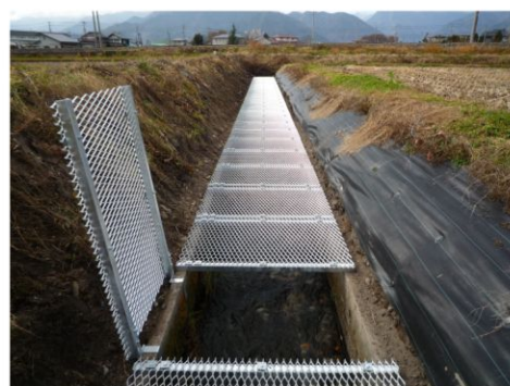
水路幅1400 開閉機構（特許出願中）
