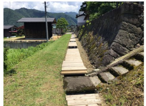
幅広い水路（板幅800）
