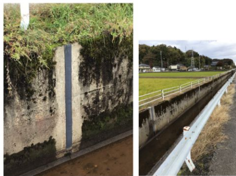
現場打ち水路
