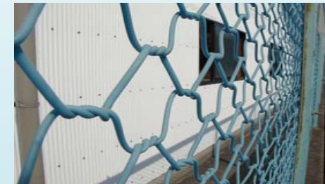
30年経過のフェンス (製造当初は青色で製作)
