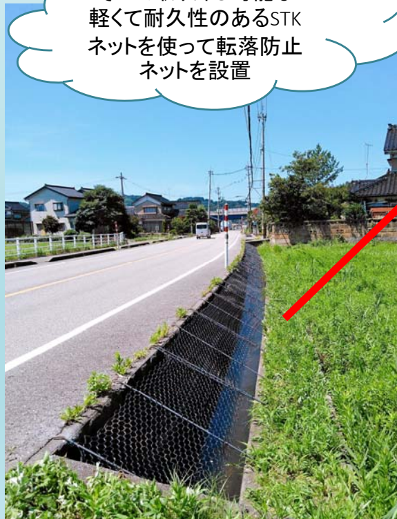
ネット施工設置後
