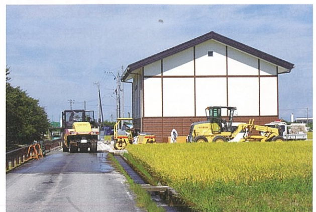
浦山新発電所外構工事
