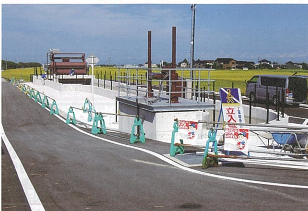
取水工外構工事
