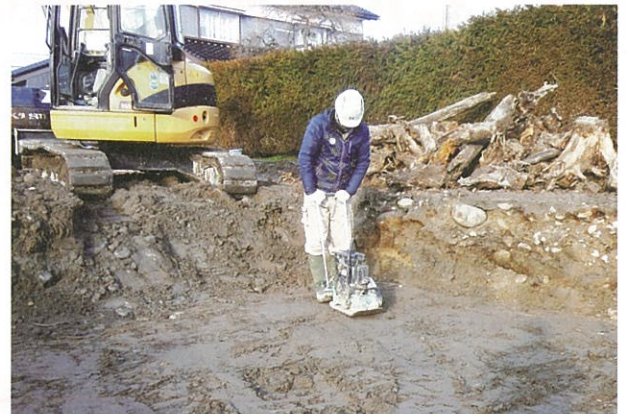
県単独事業 入善六期地区(田陥没補修)
