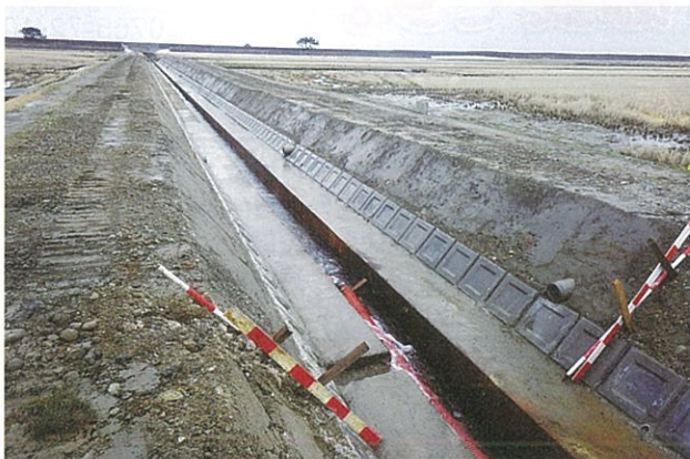
適正化事業 飯野地区(護岸補修)
