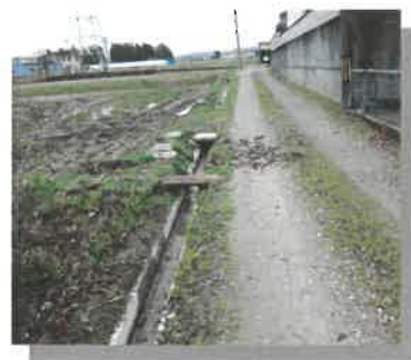
【市補助土地改良事業】 中番地区 水路整備工事 40.5m
