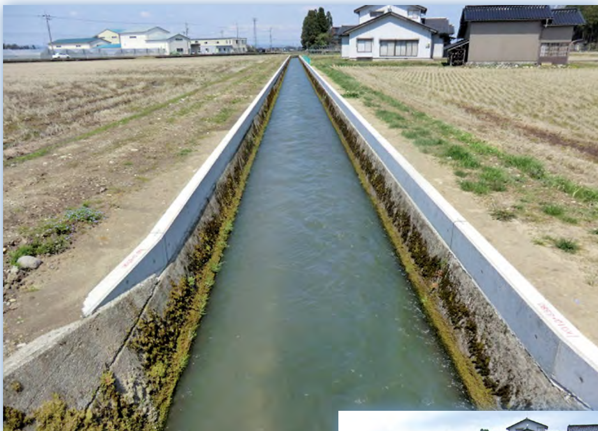
(平成25年度県単独農業農村整備事業溢水対策針山口用水地区)
