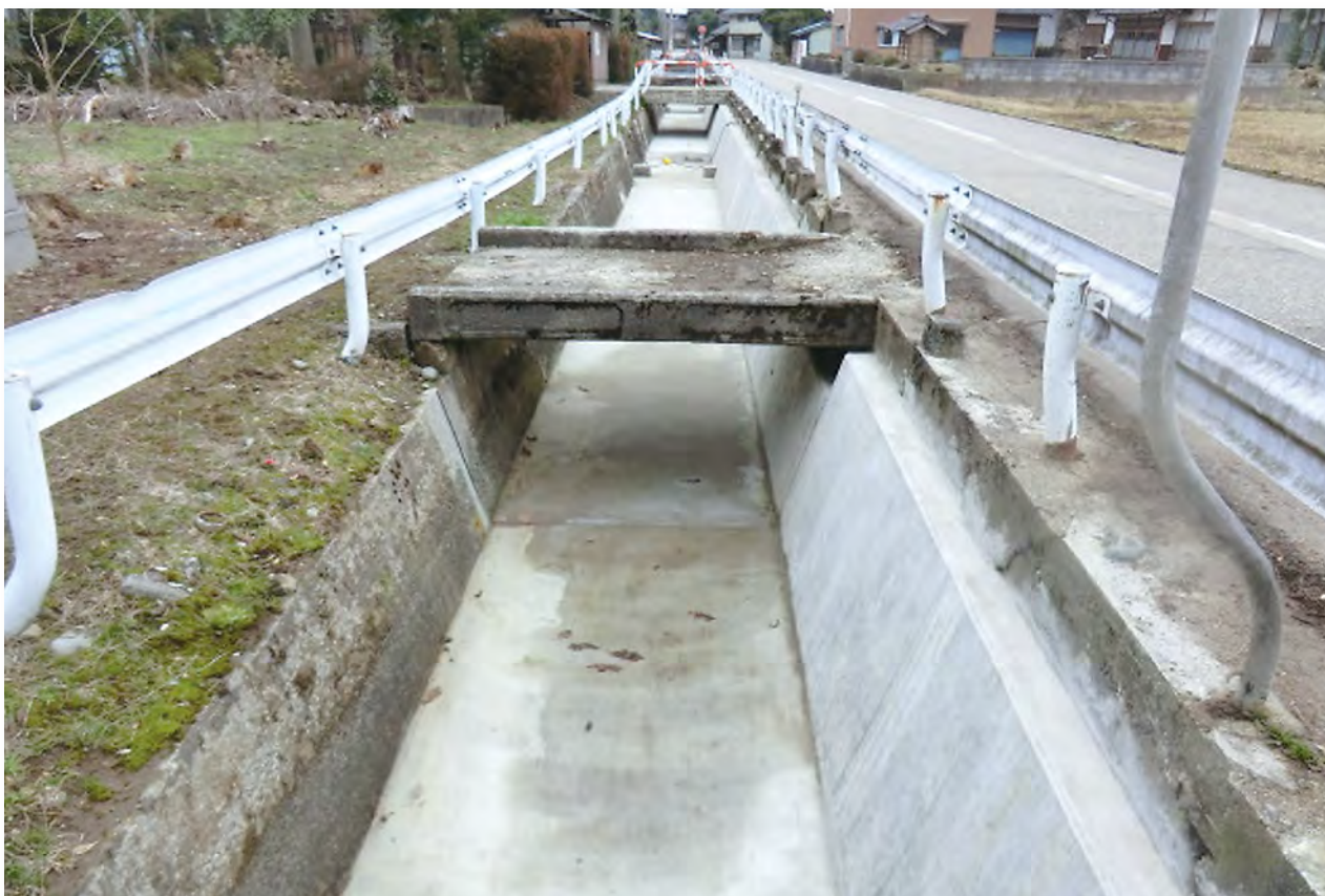
(平成26年度県営基幹水利施設ストックマネジメント事業芹谷野地区) 増山地区
