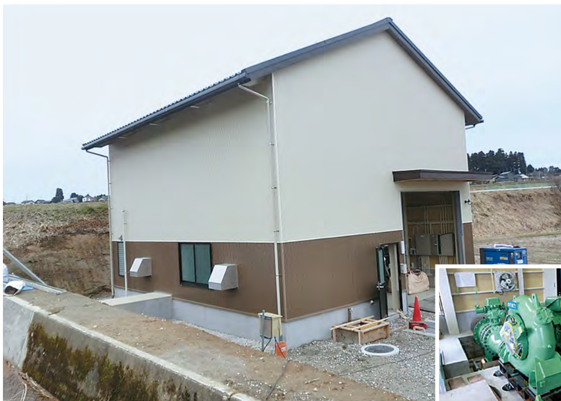
平成27年度地域用水環境整備事業芹谷野用水地区・発電所建設中
