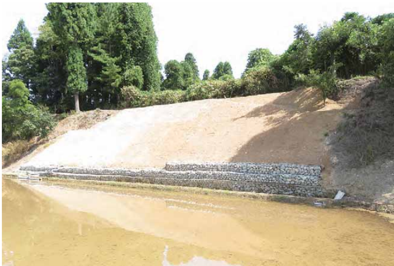
県単独農業農村整備事業（緊急） 芹谷野地区 法面補修工事（平成30年8月完成）
