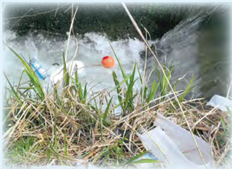
落差工に浮遊するゴミ
