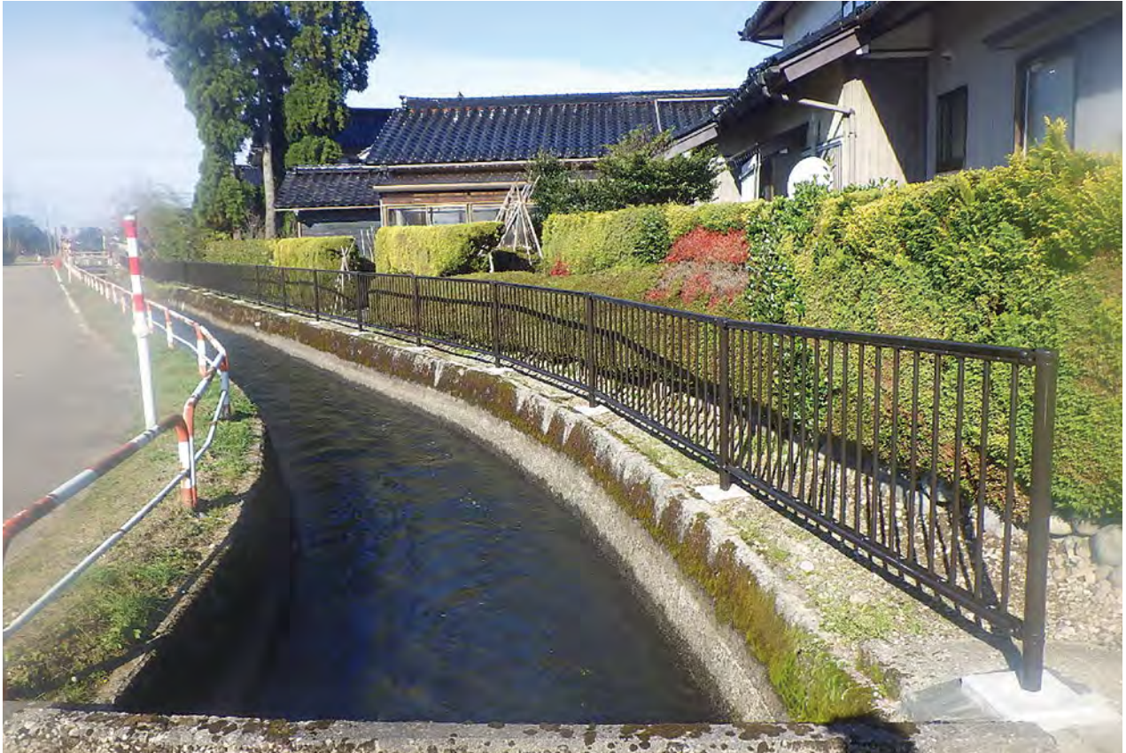
令和元年度基盤整備促進事業(農業用水路安全対策緊急整備事業)砺波幹線第1地区
