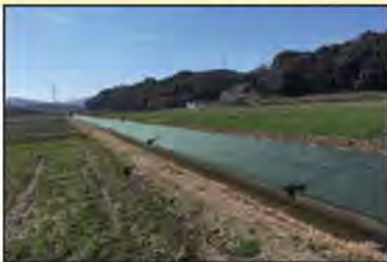
水路沿いの法面
