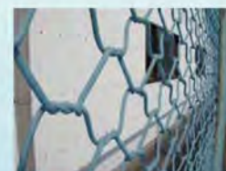
30年経過のフェンス (製造当初は青色で製作)
