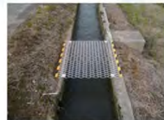
高岡市内 現場打ち水路 幅700水口周辺に敷設
