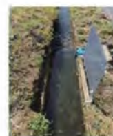
高岡市内 現場打ち水路 幅700水口周辺に敷設
