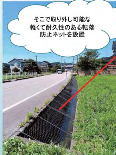
ネット施工設置後
