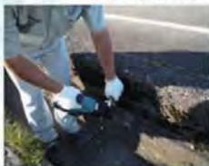
旧モルタル目地をはつります
