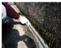
洗浄後モルタルハンチ施工
