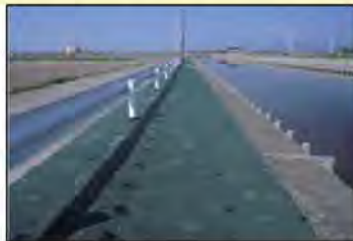
護岸工事後の現場
