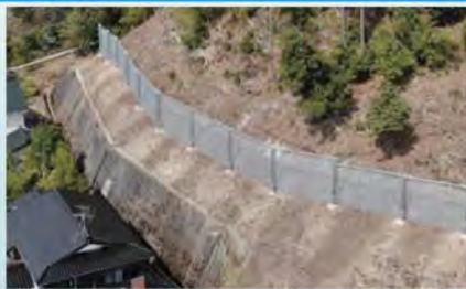
崩壊土砂防止柵 (当社で施工した工事です) ※滑川市本江
