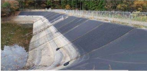
ため池での設置写真(4mピッチで長さを変えて設置)
