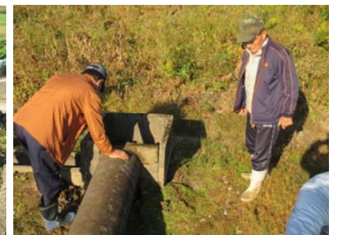
【10月16日 水路の機能診断】
