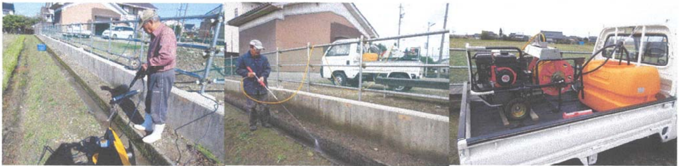
【11月3日 七口 田1704東側排水路 高圧洗浄機・自走式動噴にて清掃】
