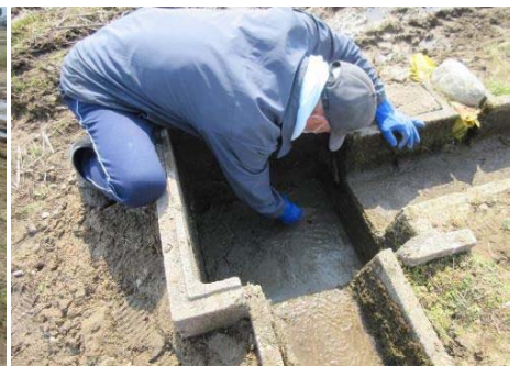
溝内の底セメント施工
