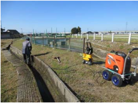
【七口 田1632北側用水路 高圧洗浄機・発電機使用にて清掃】
