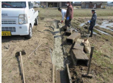
【七口 田1623北側用水路補修 U字側溝を一旦取り外して施工】
