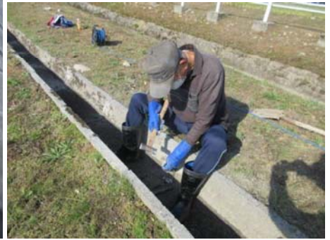
【七口 田1631北側用水路ハツリ】
