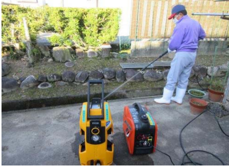
【七口 田1704東側用水路 高圧洗浄機・発電機使用にて清掃】
