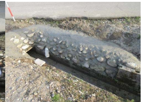
【七口 田1630東側用水路法面補修(石積みセメント施工)】
