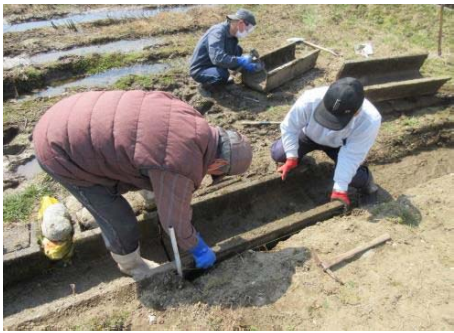
【七口 田1623北側用水路補修 U字側溝を一旦取り外して施工】
