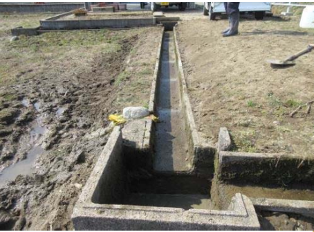
【七口 田1623北側用水路補修後】
