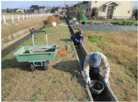
【七口 田1631北側用水路目地補修】
