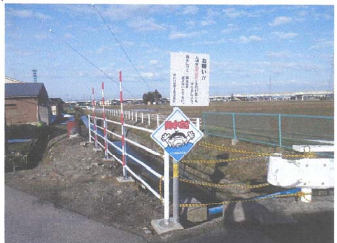
【2月11日 七口 田1570南側付近森川用水路】
