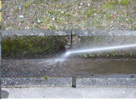
【七口 田1704東側用水路 高圧洗浄機・発電機使用にて清掃】
