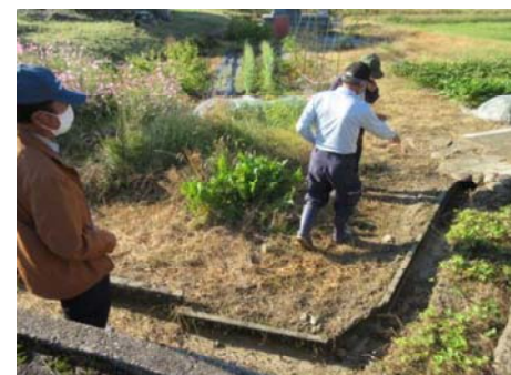
【10月16日 水路の機能診断】
