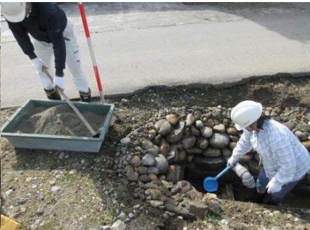
【七口 田1630東側用水路法面補修(石積みセメント施工)】
