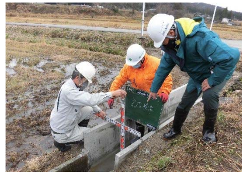
水路の補修を長寿命化事業で行いました。
