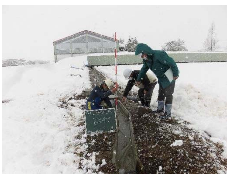
水路の補修を長寿命化事業で行いました。
