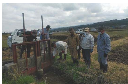
年度初めには水路、農道、農地を見廻って点検します。
