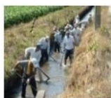
水路の泥上げ
