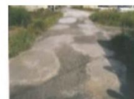
農道の窪みの補修
