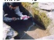
水路のひび割れ補修
