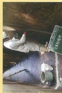
ガイメックR工法 外周部ニールタル 内修作業
