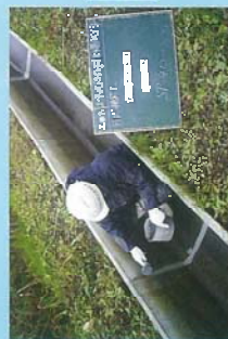
ガイメックR工法 外周部ニールタル 内修作業
