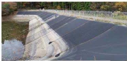
ため池での設置写真(4mピッチで長さを変えて設置)
