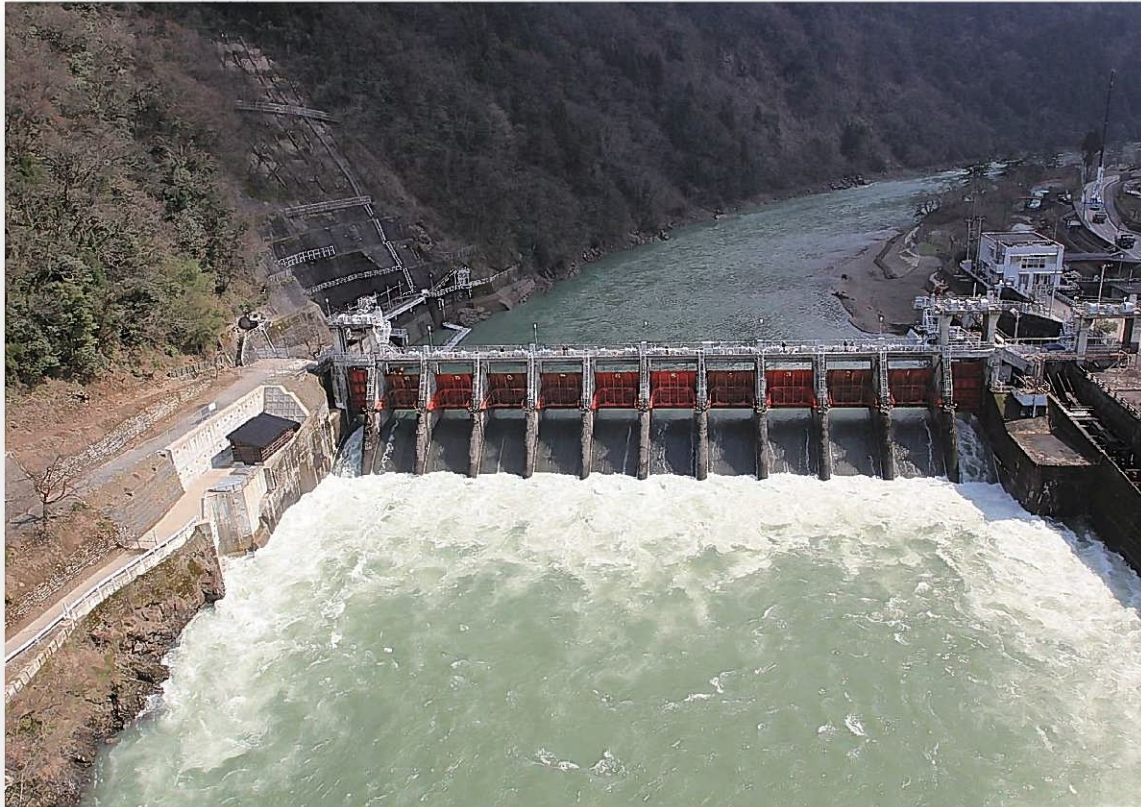
春の点検中のため放流している庄川用水合口堰堤
