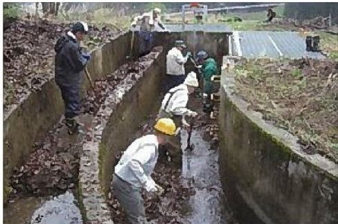
大雨後の枯葉等処理
