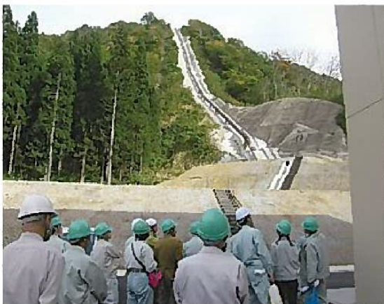
【片貝別又発電所】
