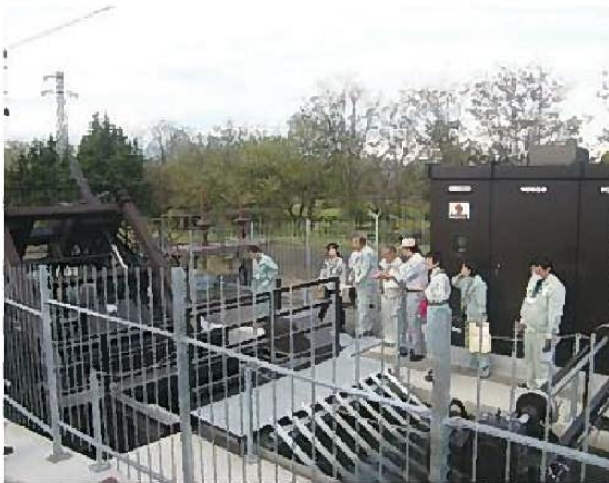
【西番小水力発電所】
