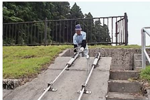
日常監理状況
