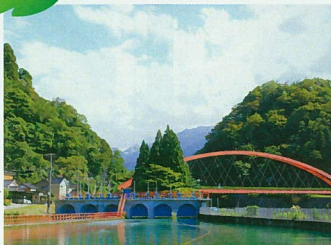
黒東合口用水 右岸沈砂池
