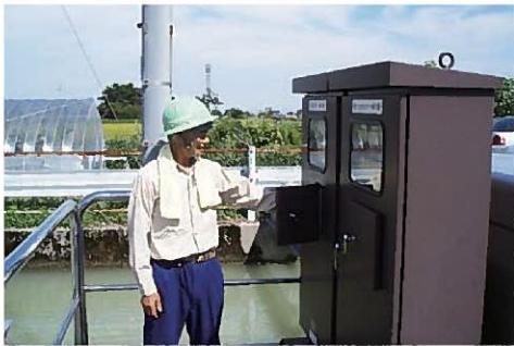
四千石用水の分水ゲート操作状況
