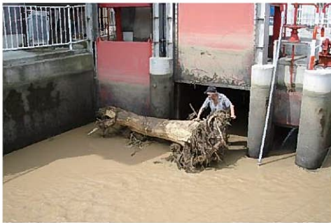
五位庄用水の西明寺川サイフォンの雑物除去作業
