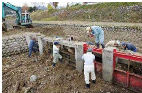
石戸用水維持管理委員会（富山市） 余水吐被災後の復旧作業状況
