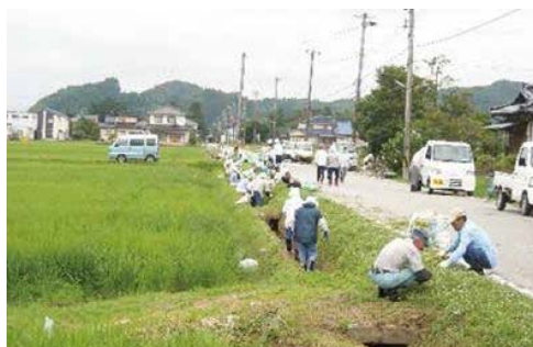
加納地区管理区（氷見市） 用水路の江ざらい状況
