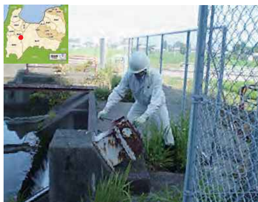
八田 浩資 氏（砺波市） ファームpond放水門の操作状況 （般若地内）
