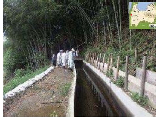
統合戸久用水利委員会（小浜市） 山腹水路の点検状況
