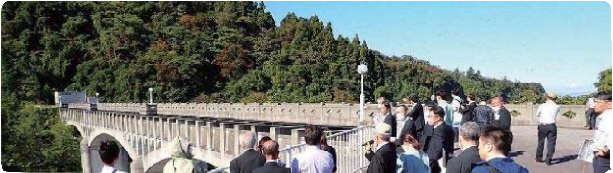
疏水フォーラムin常西用水2023 現地研修
