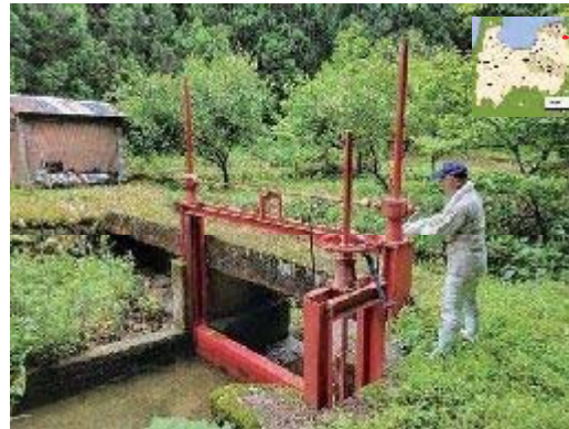
高 隆治氏（黒部市） 下高巧川取水口水門 水門の操作状況
