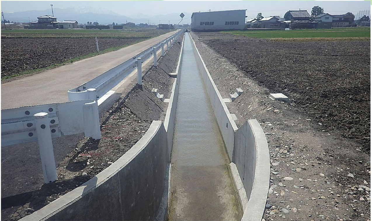
県営農地整備事業 南般若地区
