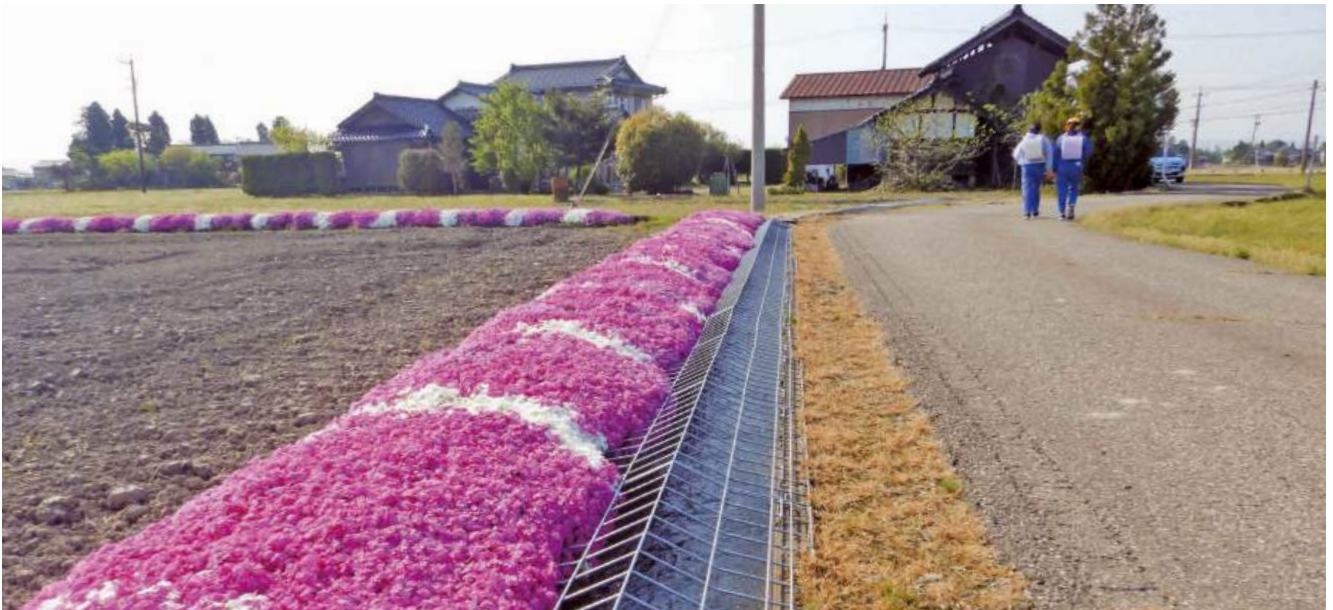
「通学路の安全対策」砺波市 野村島 地内
