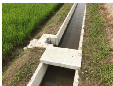
水口のコンクリート蓋の設置
