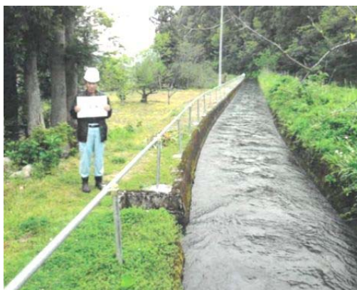
単管鋼管を用いた簡易柵
