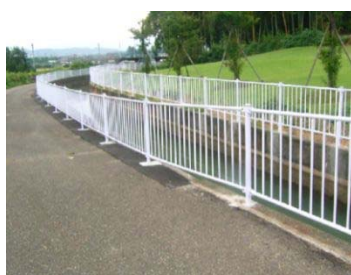
縦型防護柵(H=1.10m)
