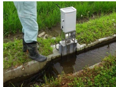
ICTによる水口水門操作
