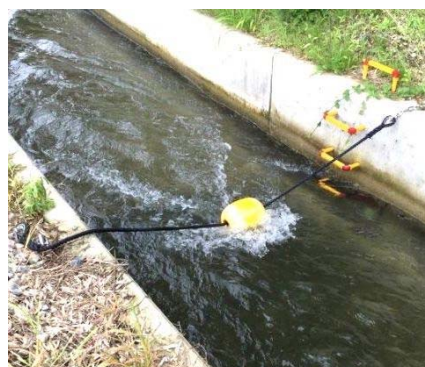
浮き、ロープ、タラップの設置
