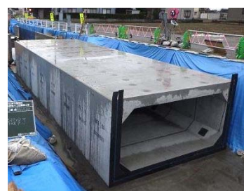
ボックスカルバートによる暗渠化
