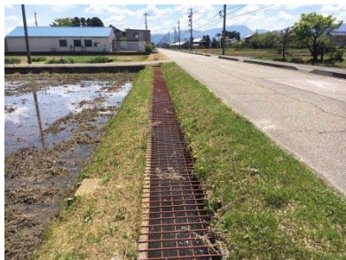
水路蓋(鉄筋網)
