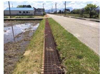
簡易な安全施設の設置
