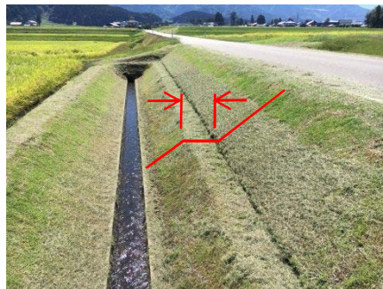
小段の設置による歩行・作業 スペースの確保
