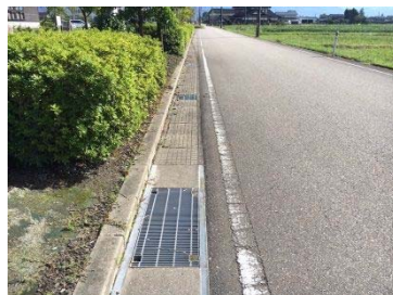
自由勾配側溝による暗渠化
