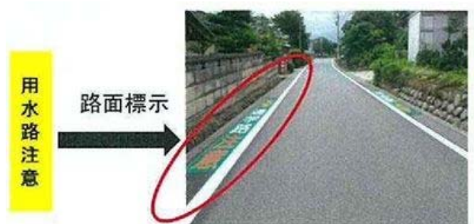
路面標示(ペイント)
