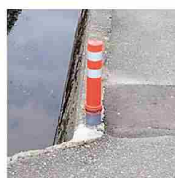
▲ポールコーンによる 視認性の向上
