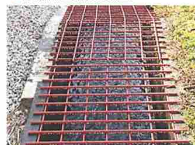
▼転落防止網の設置
