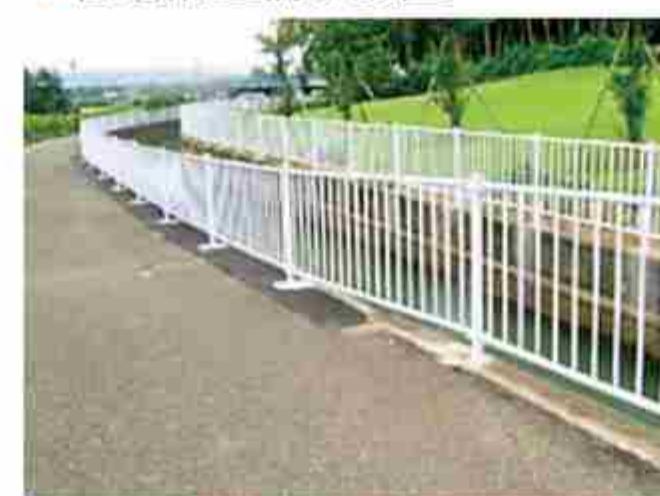
▼転落防止柵の設置
