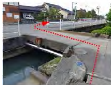
例4 水路橋梁部のクランク
