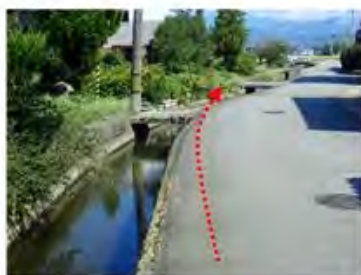
例2 カーブの外側に水路
