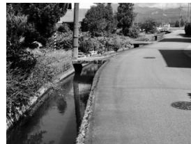
写真-3 現場イメージ （水路と道路が隣接）
