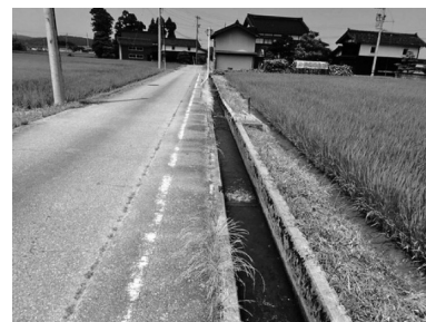
写真-1 支線農業用水路の設置環境の一例 (南砺市の庄川扇状地にて)
