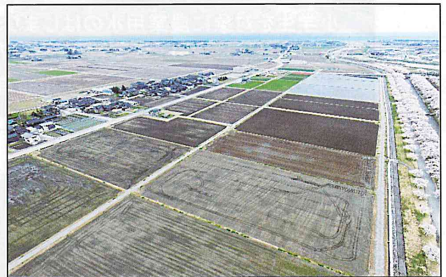
経営体育成基盤整備事業 舟川新地区 (ほ場整備工事完了後風景)
