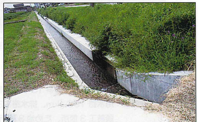
農業水利施設保全合理化事業 五箇庄北部地区 (水路改修後の通水風景)
