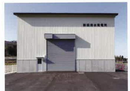
新田用水発電所
