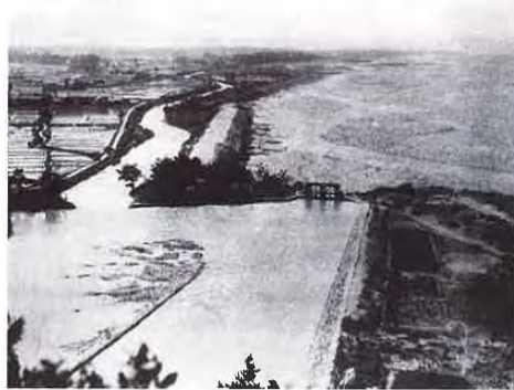
完成した常西合口用水(上滝砂溜、明治26年)
