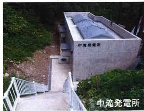
中滝発電所操作室
