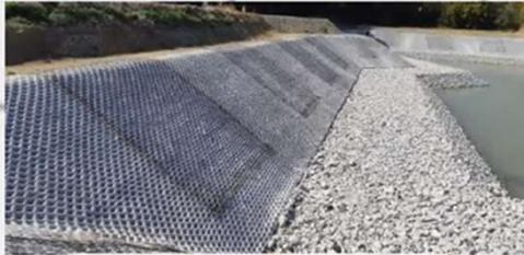
ため池での設置写真(4mピッチで設置)
