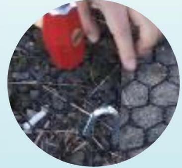
STKネットを用水の上に敷き、両サイドをアンカーなどでしっかり固定して設置します。
