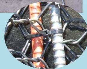
STKネットを鉄筋棒に編み込み、結束バンドで固定。連結するときは鉄筋棒同士を結束バンドで繋いで、両端はアンカーなどで固定。
