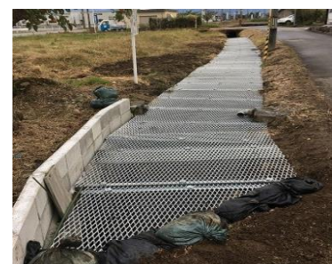
下番地区 水路蓋掛け工事
