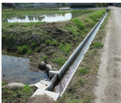
善名地区 水路整備工事
