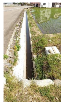
善名地区 水路整備工事
