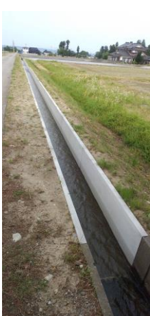
桑原地区 水路整備工事
