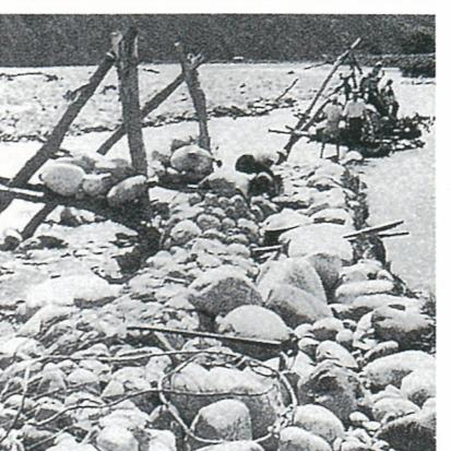
土地改良改修前の用水取水五厘堰ぞいに取水堰までの郷川・北野共同導水江（『滑川市史』通史編所収）
