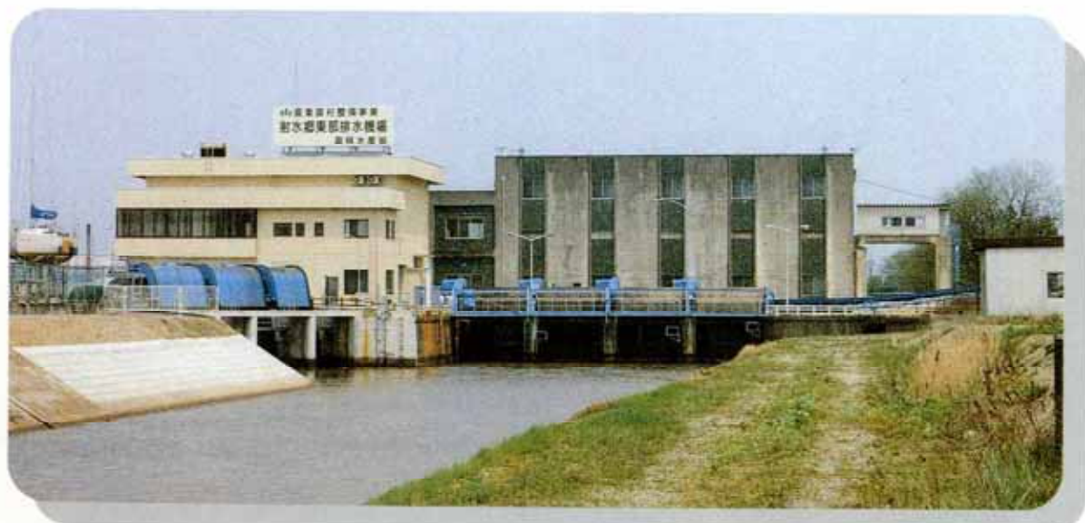
東部排水機場
