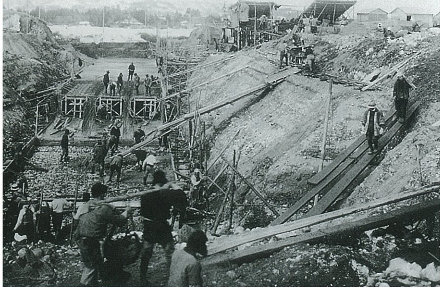
牛ヶ首用水井田川サイフォン工事（昭和9年）
