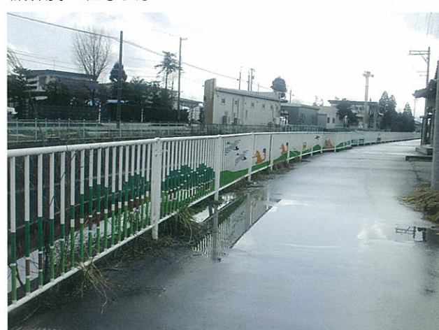
防護柵（富山市婦中町下条地内）
