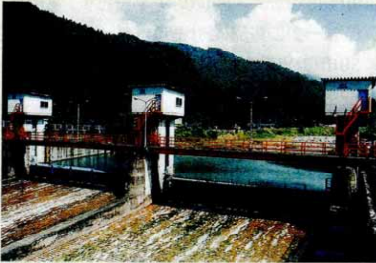
くろだにとうしゅこう ごうくちしゅすいこう くろだに 黒谷頭首工（合口取水工・黒谷）
