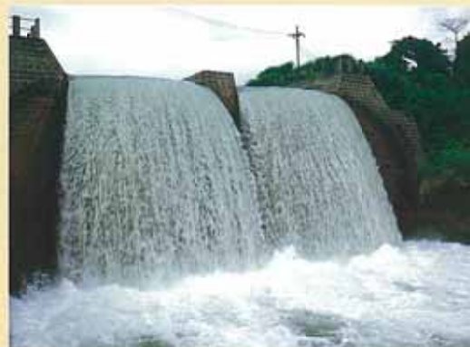
迫力ある水の流れの大落差工（落差約12m）
