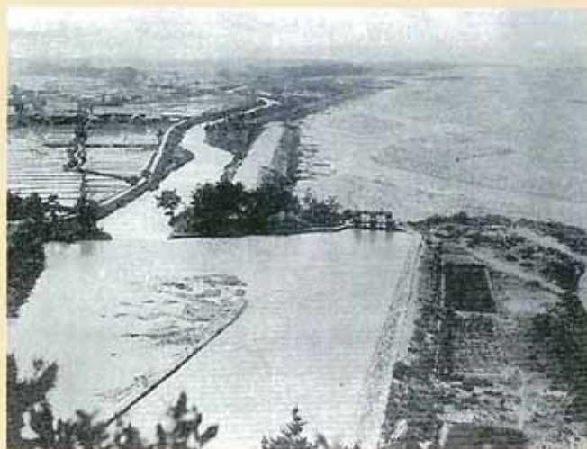
完成した常西合口用水路 （提供：常西用水土地改良区）
