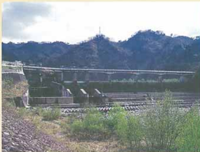
左右岸の取水口が横江頭首工に一本化
