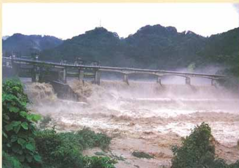
横江頭首工を流下する土石流
