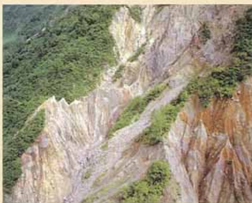
流出を続ける鷲山崩壊の堆積土砂 （出典：常願寺川の上流をたずねて）
