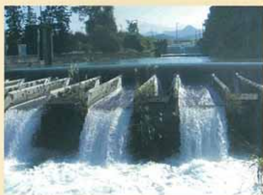
正確な分水の工夫が見た目にわかる
