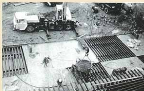
耐摩耗レールの設置
