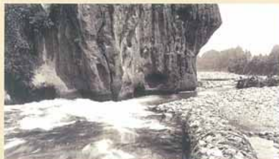
合口後の取水口（鷹泊取水口） （出典：常西合口用水 パンフレット）
