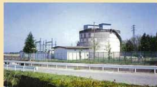
農業用水を有効利用する常願寺川第三発電所 （出典：常西合口用水 パンフレット）
