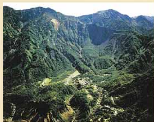
鷲山崩壊地直下に位置する 多枝原平の砂防施設 （出典：常願寺川の上流をたずねて）
