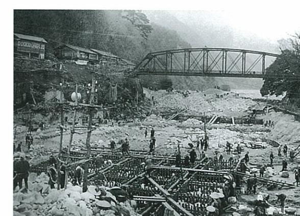
旧愛本堰堤木工沈床工事（昭和6年）
